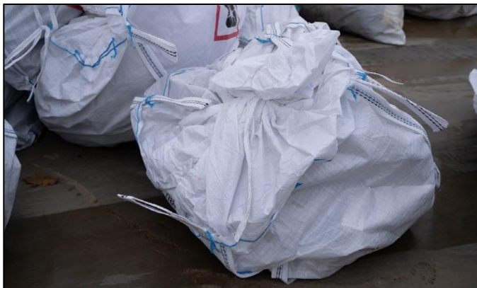
Ordnungsgemäß verpackter Big Bag mit Akustikdämmplatten
